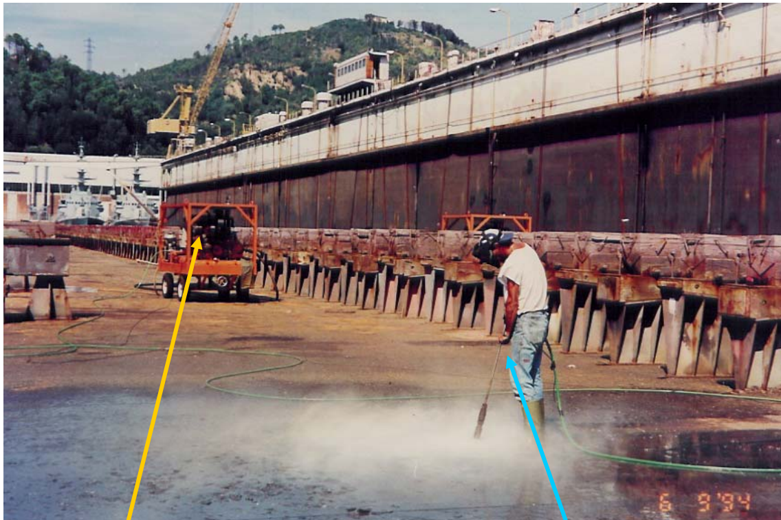
Hochdruckaggregat mit Dieselmotor und KAMAT Pumpe Typ: K 9018 A (25 l/min. bei 1200 bar)
