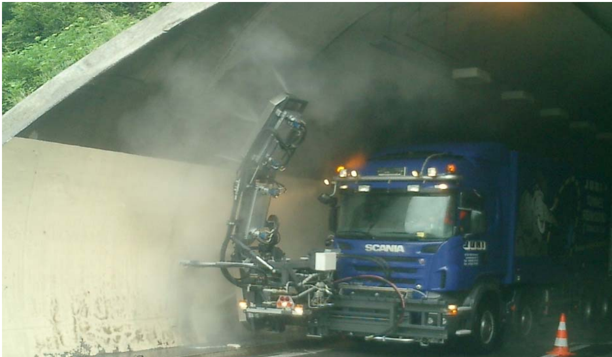
Bild oben: Das Spezialfahrzeuge TCT 400 H im Einsatz. Die vordere Düsenbalkenkonfiguration kann hydraulisch dem jeweiligen Tunnelprofil angepasst werden.
