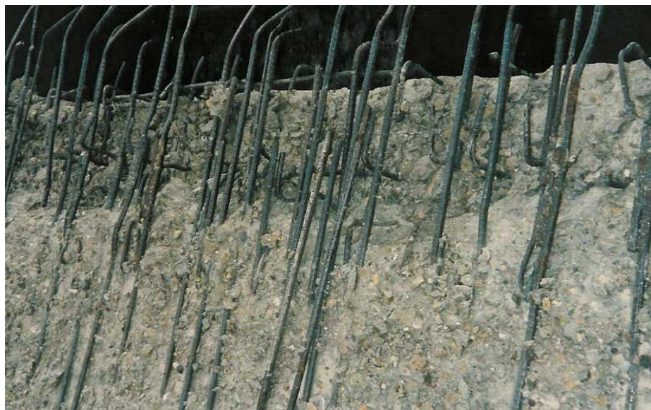
Die Betonanschlussflächen und die freigelegten Bewehrungs- eisen nach der Bearbeitung
